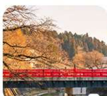
สะพานนากะบาชิ
